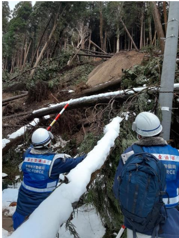
被災状況調査（輪島市打越町）
