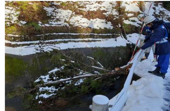
被災状況調査 （輪島市房田町）
